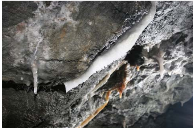
Abbildung 29: Calcitablagerungen an der Firste im Wasserstollen (MP 03), Foto: WOLKERSDORFER
